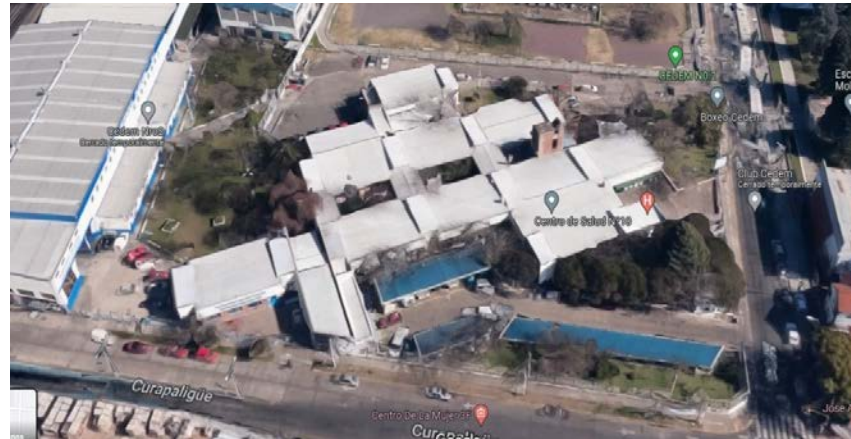
Vista aérea del sector a intervenir
