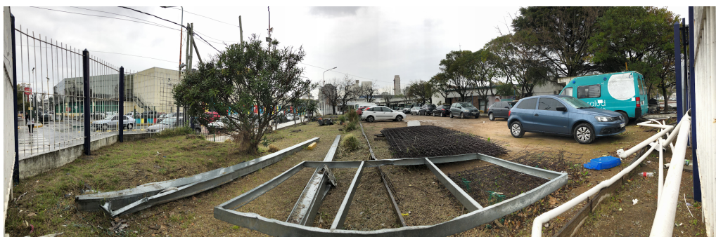
Vista del sector a intervenir desde el interior del predio (esquina de las calles Alberdi y Curapaligüe)
