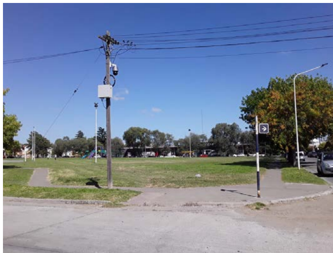
Vista desde la esquina de calle Italia y calle Venezuela
