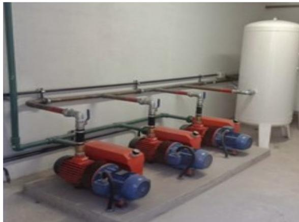
UNICA A PISTON Y CARTER SECO, SISTEMA PENDULAR DE SOLO UNA BIELA - OIL FREE- LIBRE TOTALMENTE DE ACEITE LUBRICANTE EN TODAS LAS ETAPAS DE SU FUNCIONAMIENTO, para un régimen de trabajo como el que detallamos a continuación:
